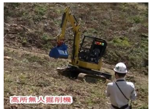
図2 高所無人掘削機（リモコンで操作）
