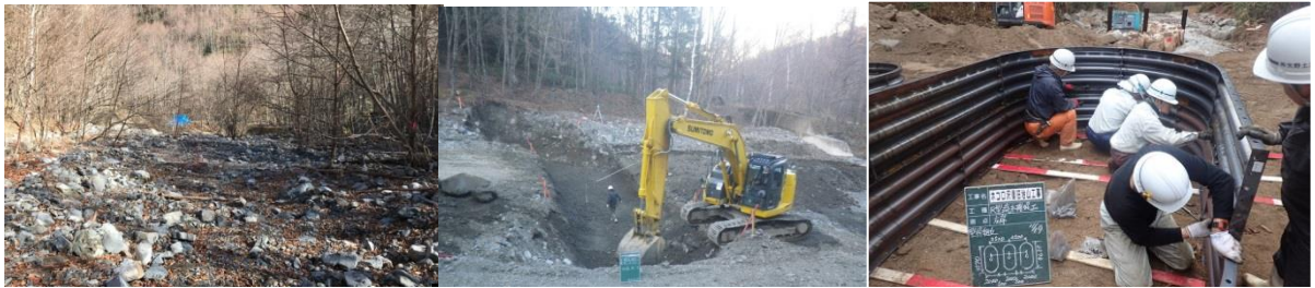
設置前（上流側より） → ①床掘 → ②ライナープレート組立
