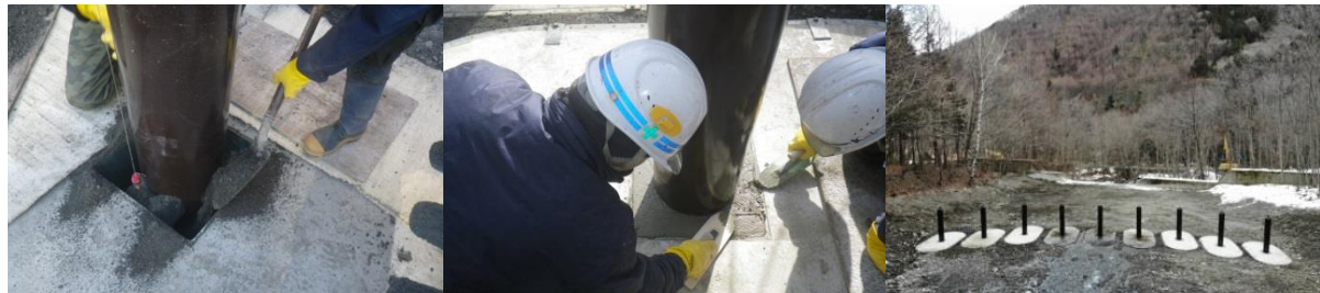
⑦-2 砂充填 → ⑦-3 コンクリート充填 → 設置完了（上流側より）
