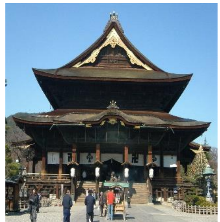
写真－1 善光寺の檜皮葺屋根
