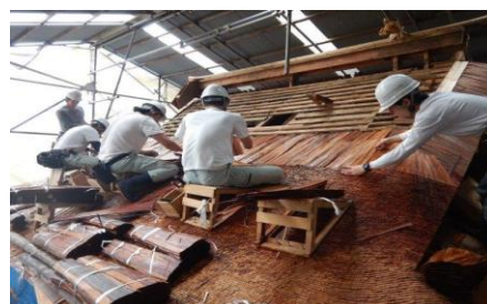
写真-15 屋根に檜皮を葺く様子
