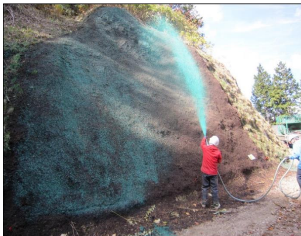
植生基材吹付工への吹付
