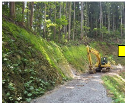
〔施工から 3 ヶ月後〕
