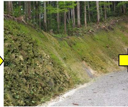
〔施工から 2 ヶ月後〕
