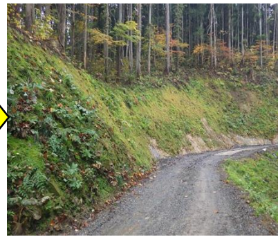
〔施工から 5 ヶ月後〕
