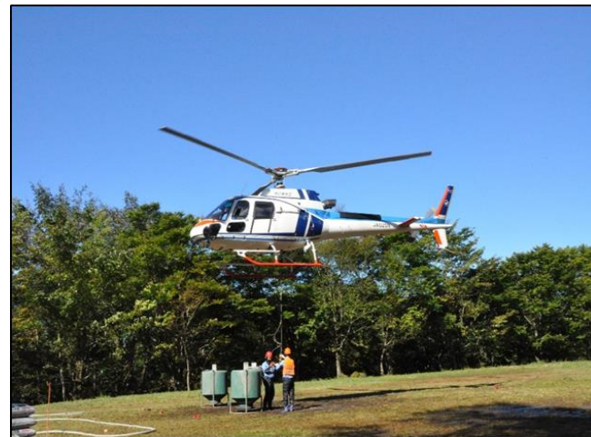
BSC を資材に混入し散布(航空実藩工)
