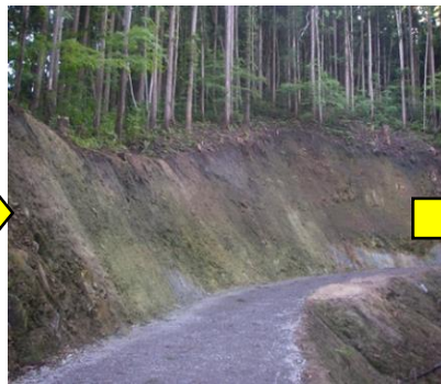
〔施工から 1 ヶ月後〕
