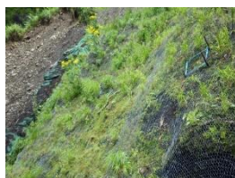
写真－7 遠景 第2工区（令和元年度）
