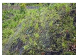
写真－10 遠景 第3工区（令和元年度）
