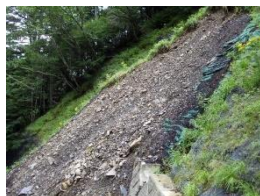
写真－4 遠景 第1工区（令和元年度）
