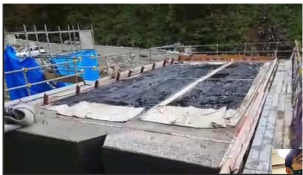
写真2 遠隔臨場の状況
