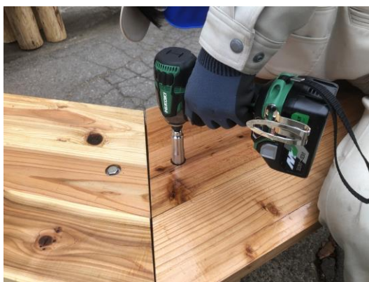
図4 組み立ての様子
