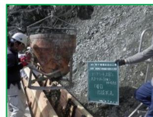
写真7- コンクリート打設
