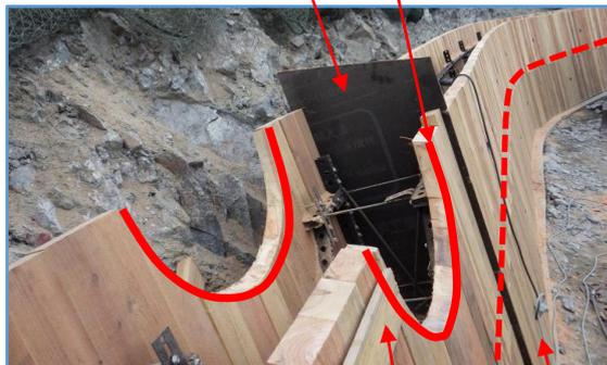
写真 18- 木製残存型枠
