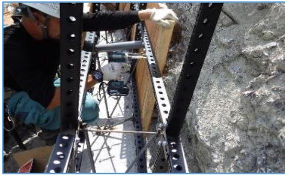
写真 16- 木製残存型枠設置
