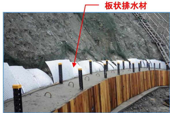
写真 17- コンクリート打設完了
