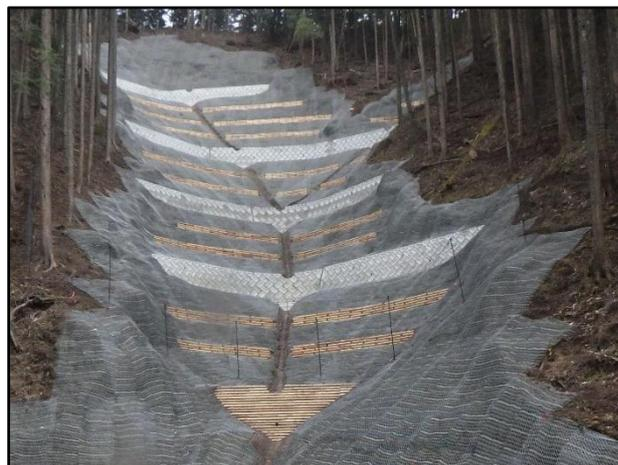
写真-3：L型筋工
