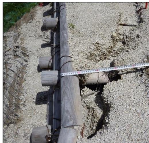
写真-2：丸太筋工(B)の土砂流出状況
