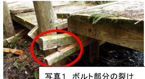
写真1 ボルト部分の裂け
