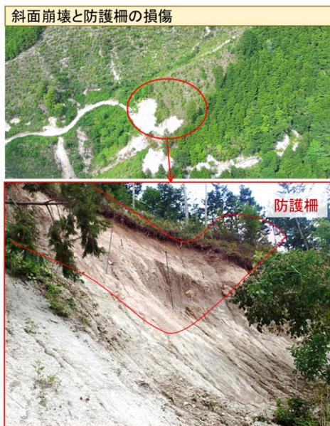
図—1 真砂土地域の斜面崩壊による防護柵損傷箇所
