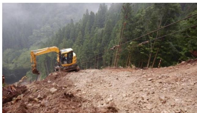
写真－2 機械のり切工の様子
