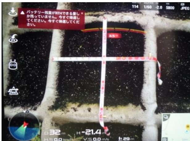
写真-6：モニターによる法枠寸法の確認
