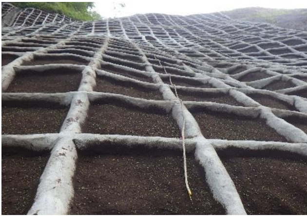
写真－２：簡易法枠工
