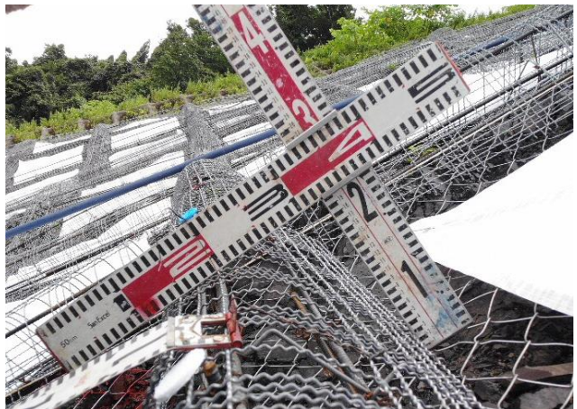
写真-7：法枠断面の近景
