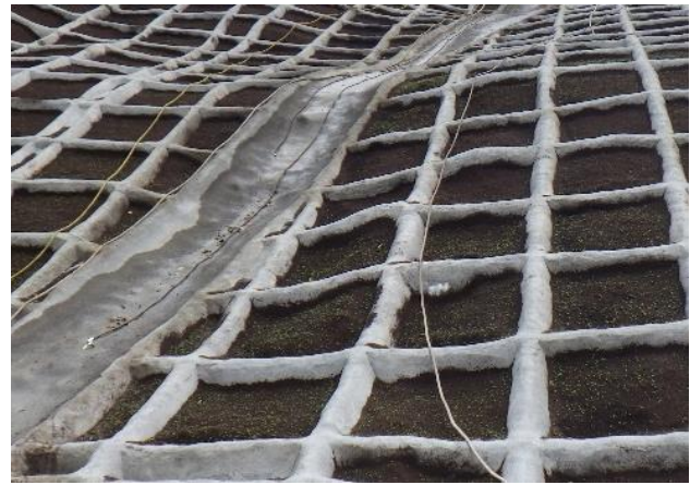
写真－３：モルタル吹付工
