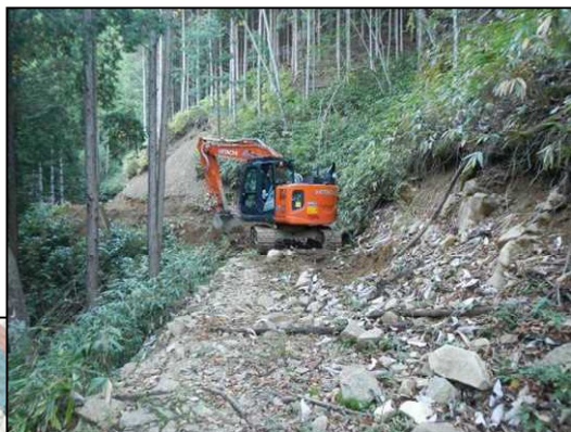
作業道の補修(令和4年度)
