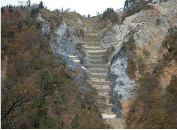
写真6 Bブロック施工状況(2003年)
