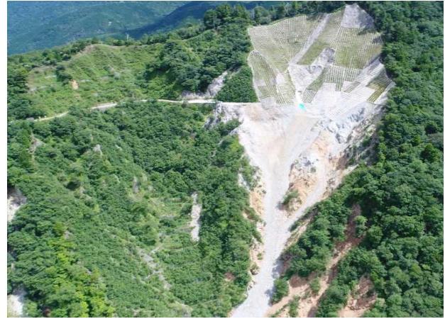
写真8 Bブロック施工後状況(2021年)
