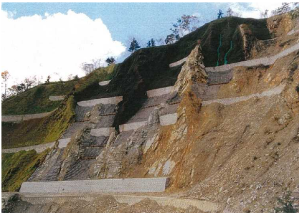
写真2 Aブロック施工状況(1999年)
