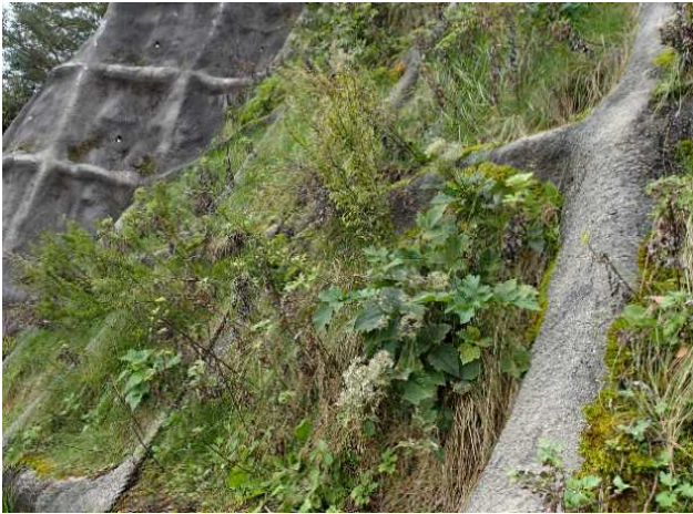
写真10 Cブロック施工後8年経過の状況(2022年)
