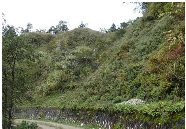
写真3 Aブロック施工後状況(2017年)
