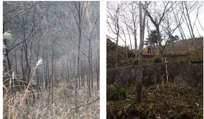
写真7 Bブロック植栽工施工後状況(2022年)
