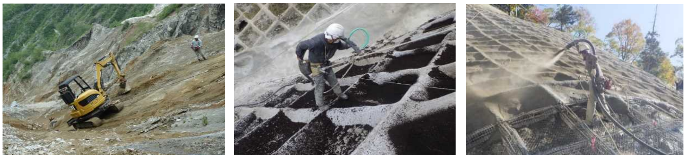
写真9 Cブロック施工状況(2015年)
