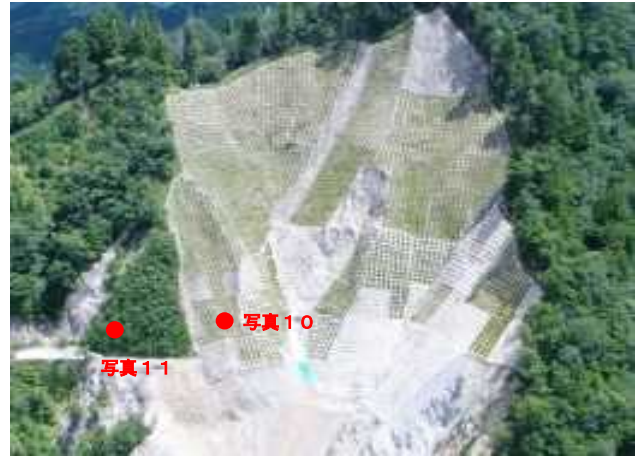
写真12 Cブロック施工後状況(2022年)
