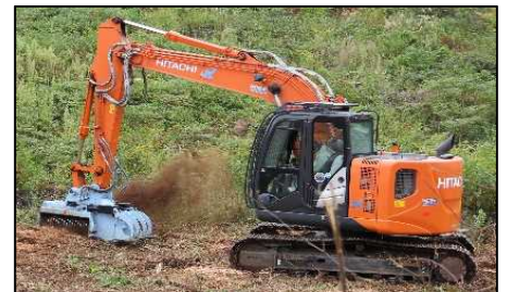
写真5：クラッシャー作業状況
