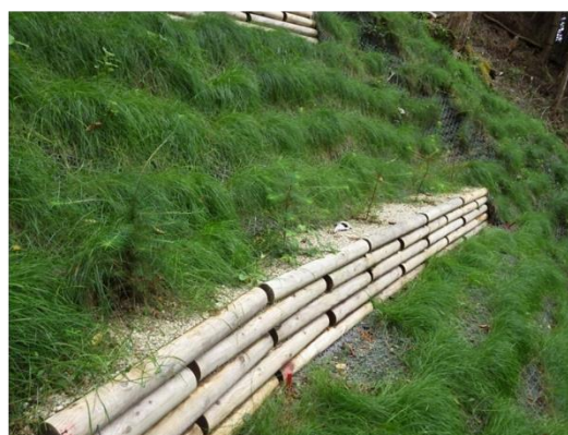
写真-11：従来工法の丸太筋工(B) (左) と採用工法のL型筋工 (右)
