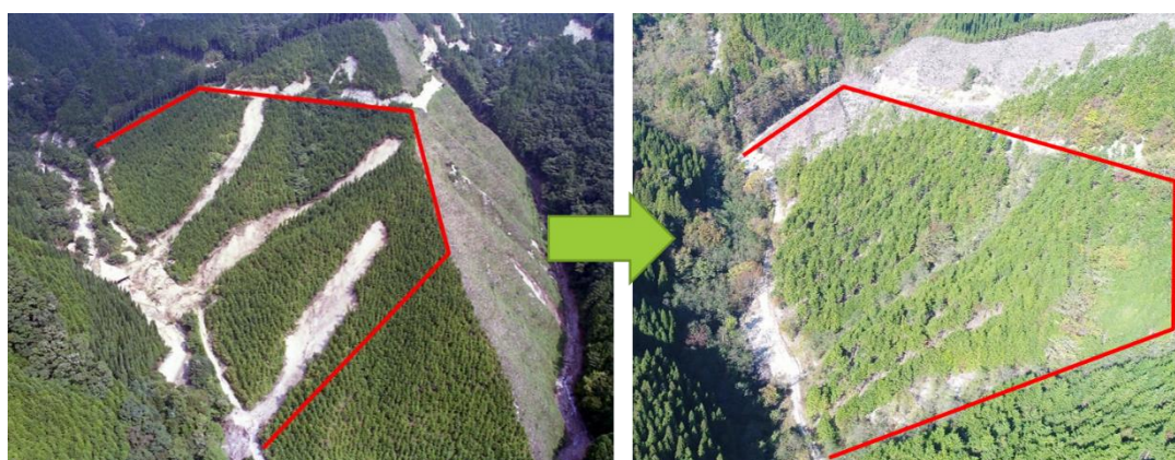
写真-8：災害直後と復旧後15年経過(白井沢)
