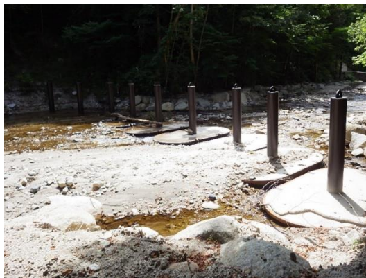
写真-10：R型流木捕捉工
