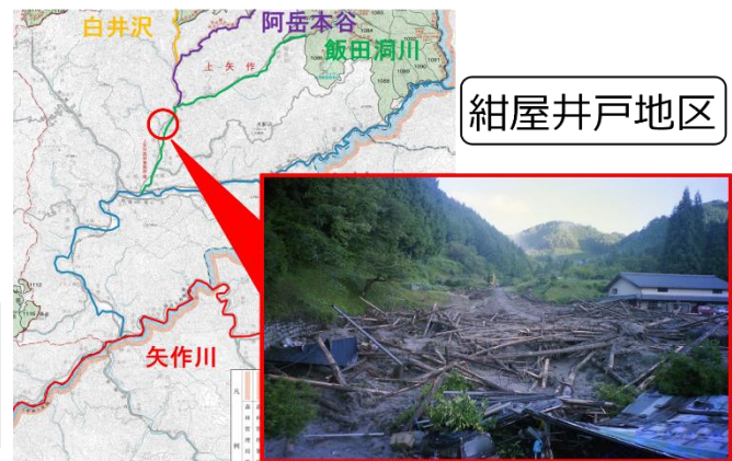
写真-2：上矢作町の被災状況
