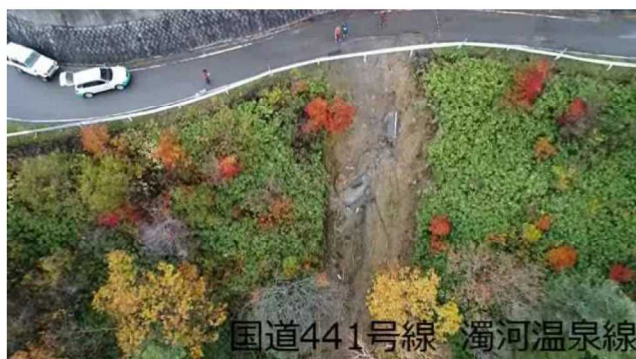
図4：国道441号線 崩落箇所
