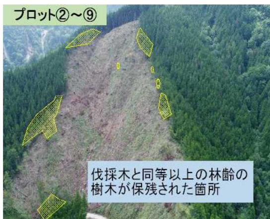
写真-7 プロット②~⑨全景
