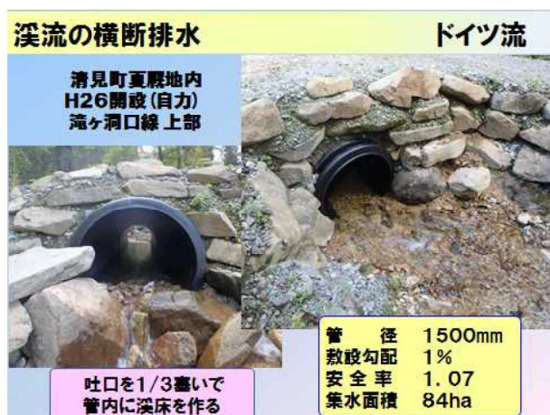
写真-7 ドイツ流の渓流横断排水
