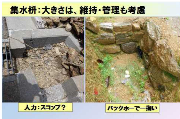
写真-5 水受口構造
