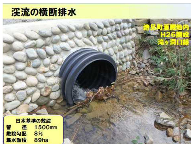
写真-6 渓流の水受口構造
