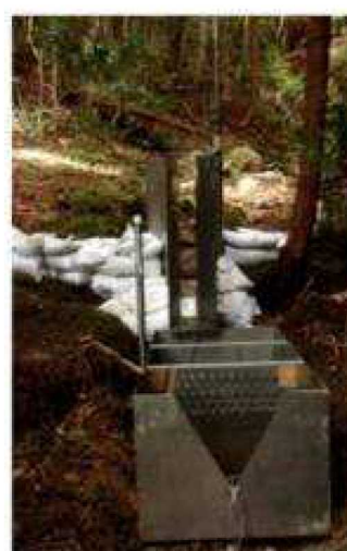
図 6. 河川流量観測機器（三角堰）
