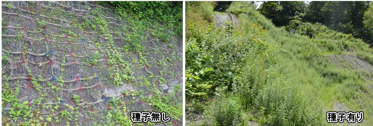
写真－1 植生マット伏工比較（施工後1年）
