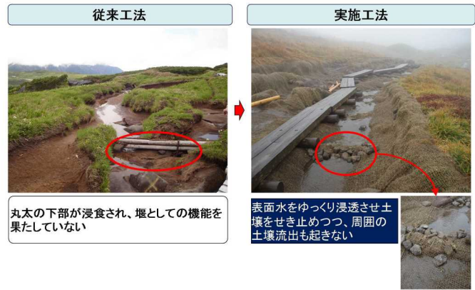
図8 従来工法と雲ノ平で取り組んだ施工方法の比較
