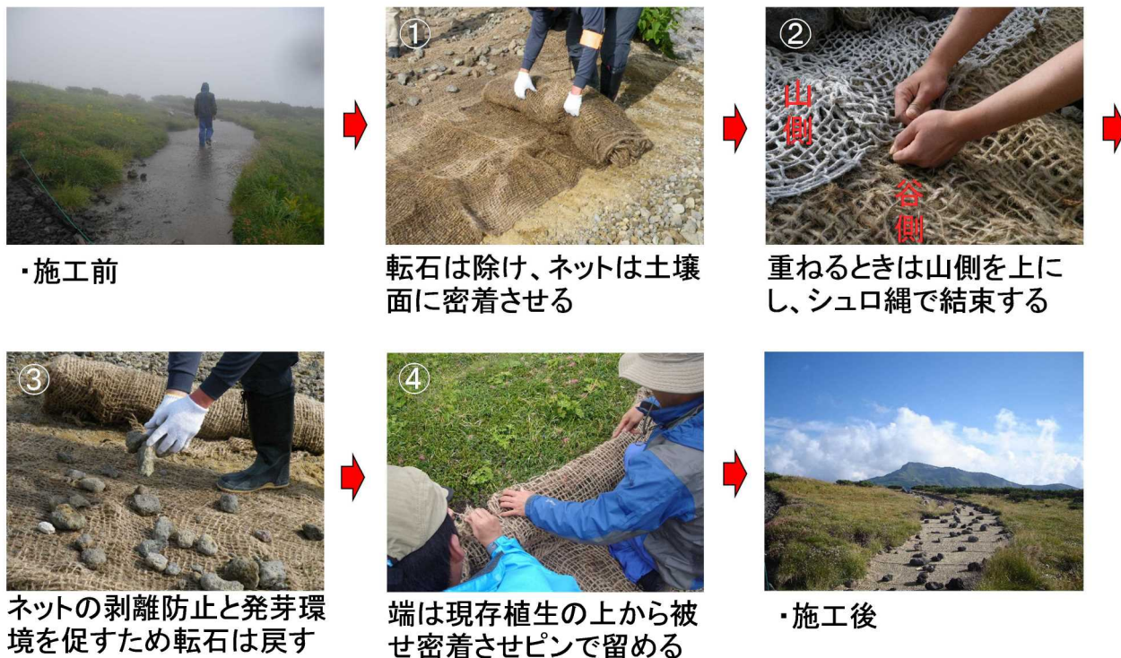
図11 伏工の施工手順
