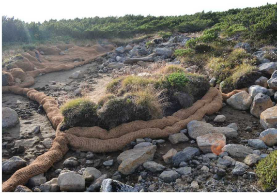
写真1 雲ノ平で実施した施工様子
