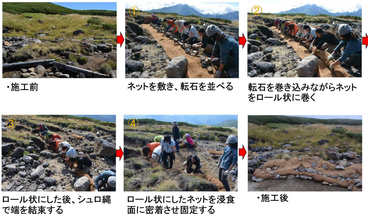
図1 2 土留工（ロール工法）の施工手順
