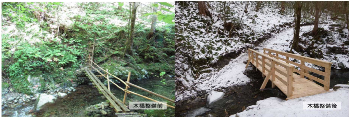
図5 改修前後の木製橋梁状
