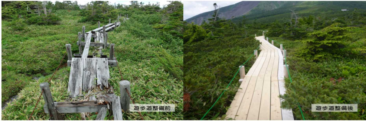
図4 改修前後の木製歩道状
