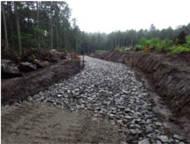
写真11 割栗石の敷設
