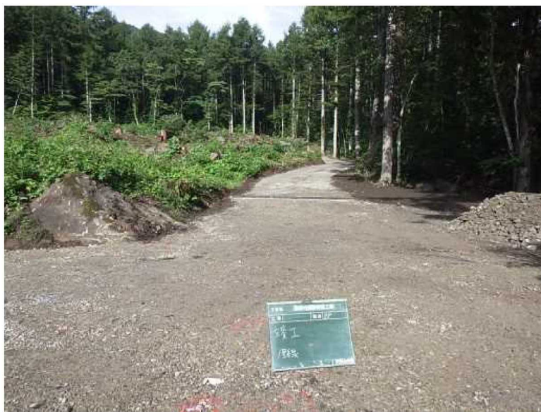
写真19 完成した付属路1号線
