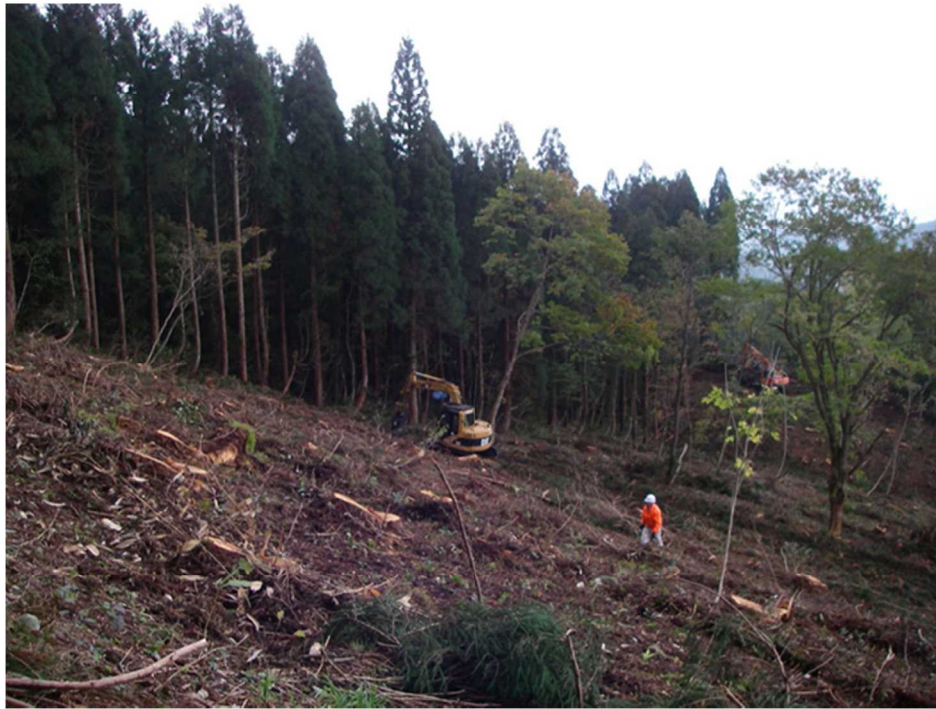
写真14 生産事業地2での車両系機械地拵
