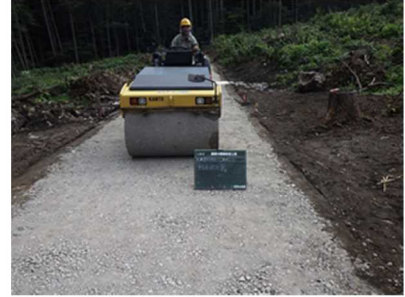
写真13 上層路盤ローラー掛け
