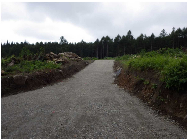
写真20 完成した付属路2号線
