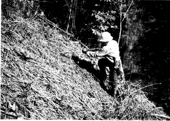
地かき作業実行状況
