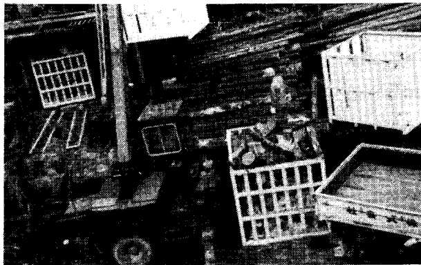
鉄製コンテナー利用による搬出状況
