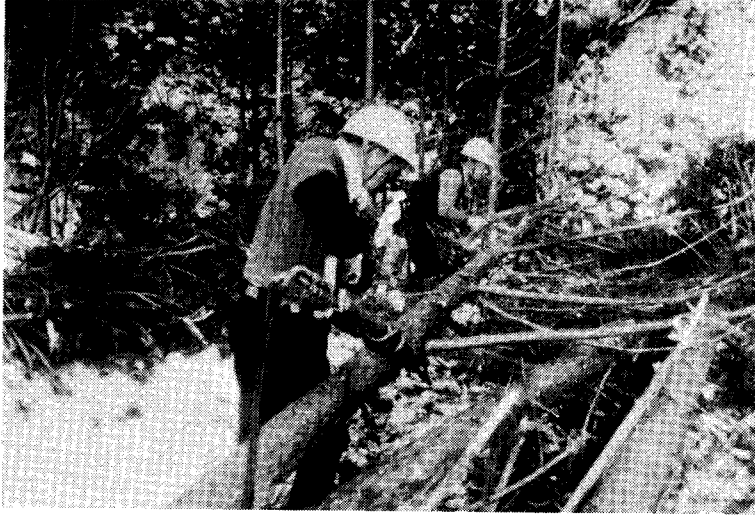
枝払機による枝払作業（盤台上）
