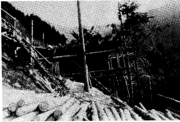
滞荷盤台と、盤台組上げ状況
