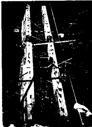
写-1 工事施工中
