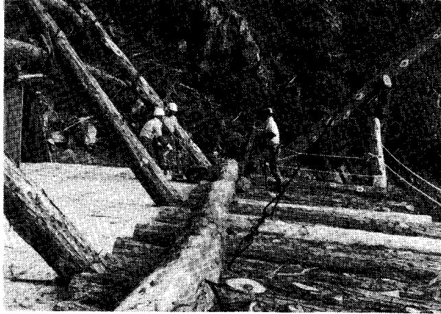
脱荷フック利用鋸断中
