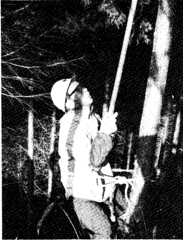
谷側での作業状況
