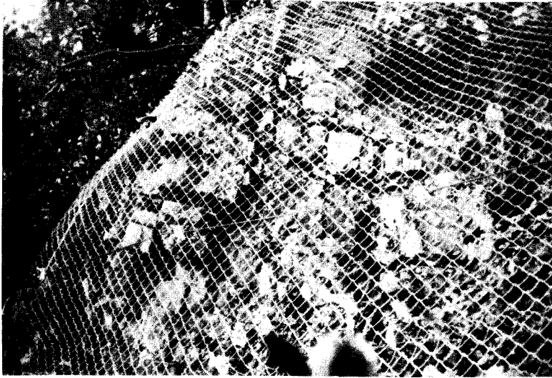
落石危険ヶ所を部分的に防護した状況
