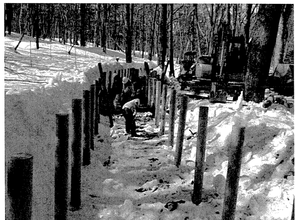
写真5 木道の改設工事
