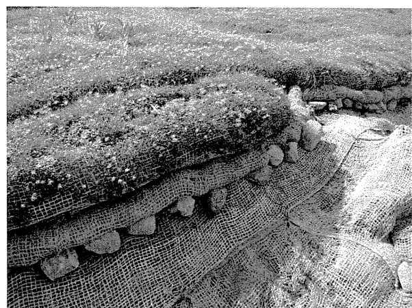
写真5 崖部の施工（ロールを転石で留める）
