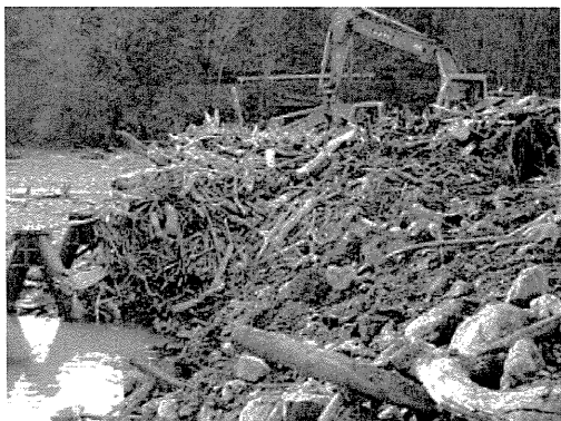
写真-5 流木取り除き
