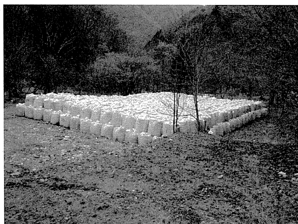
写真-14 大型土のう袋積み上げ
