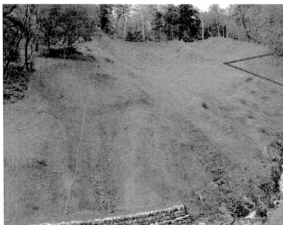
写真-20 吹付工完了
