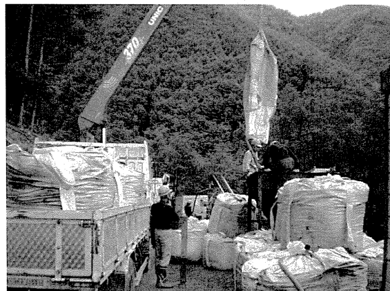
写真-18 基材投入
