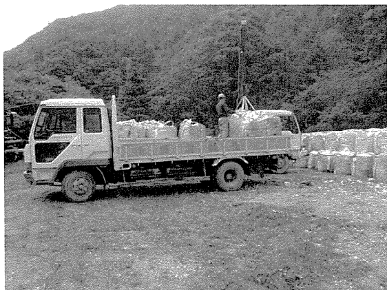
写真-17 基材積み込み
