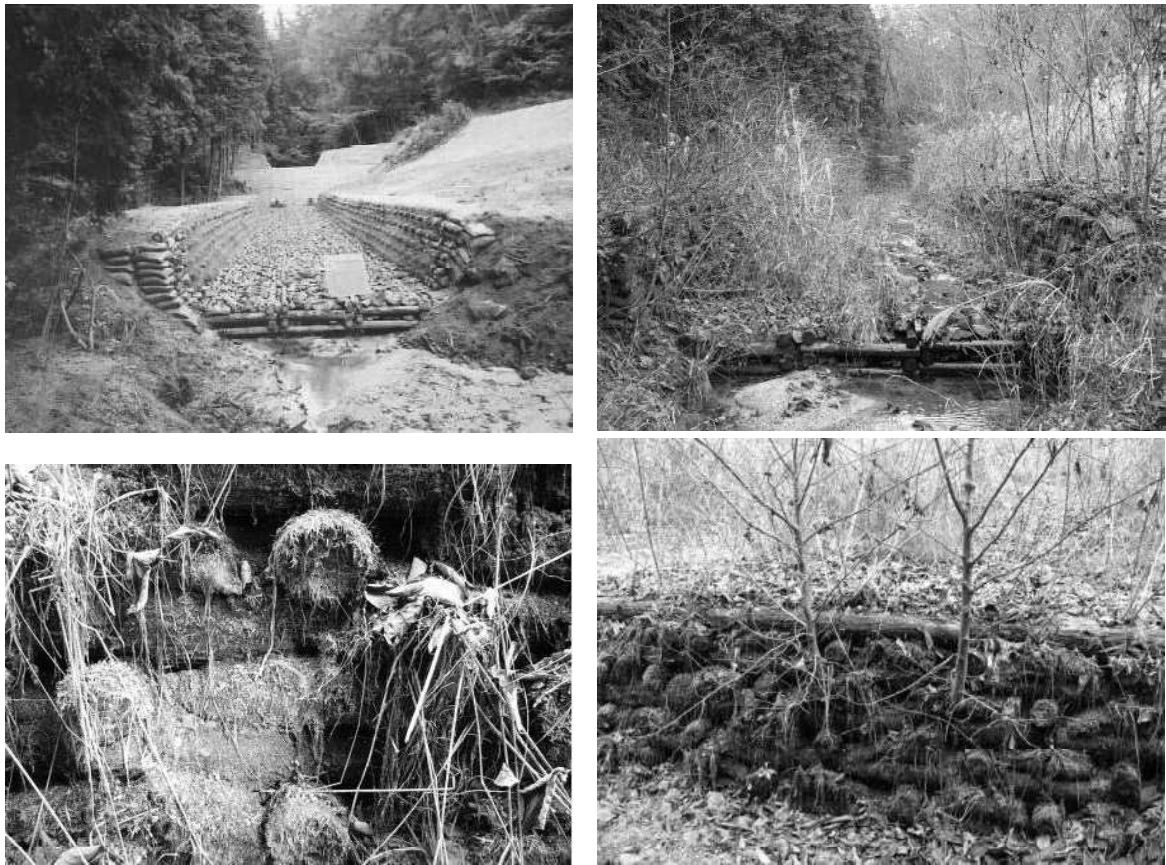
写真-4 大ヶ蔵連（アンコ沢）施工直後（左上）と現在の状況（5年経過）
