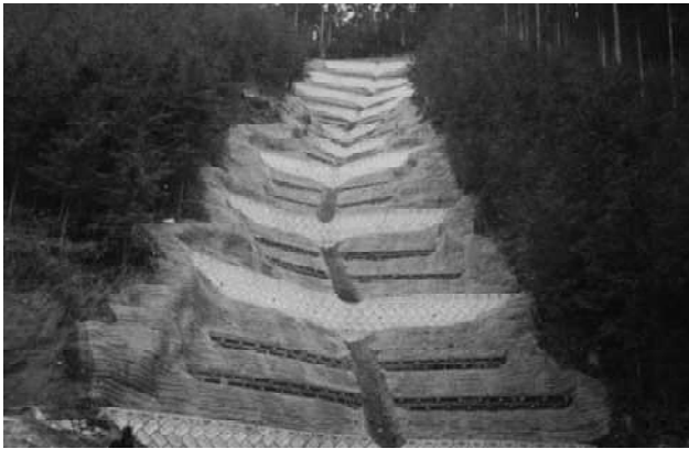
写真－4 施工直後
