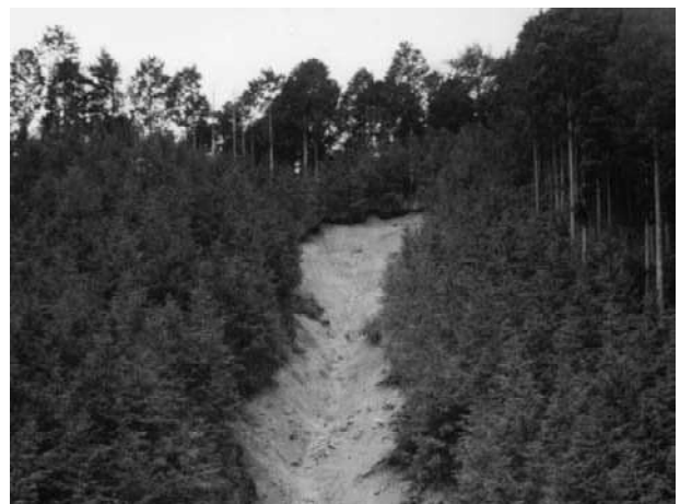
写真－1 表層崩壊
