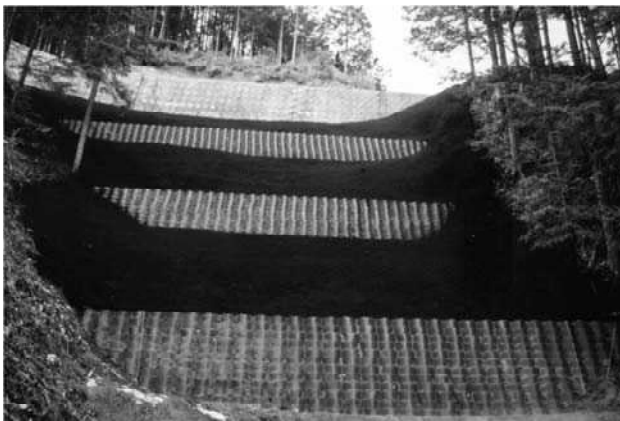
写真－14 施工直後
