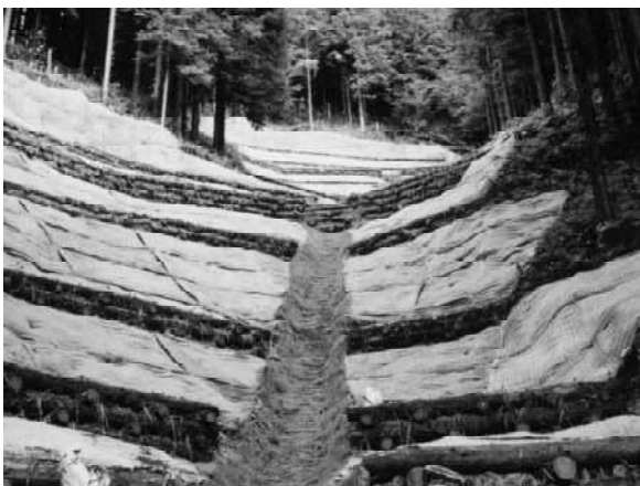
写真－8 施工直後
