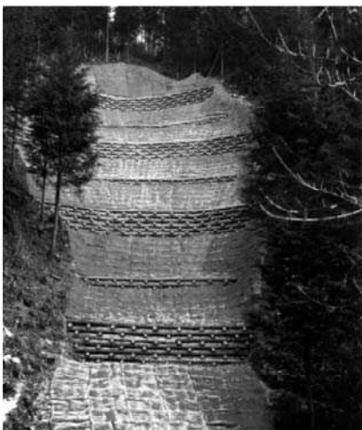
写真-11 施工直後
