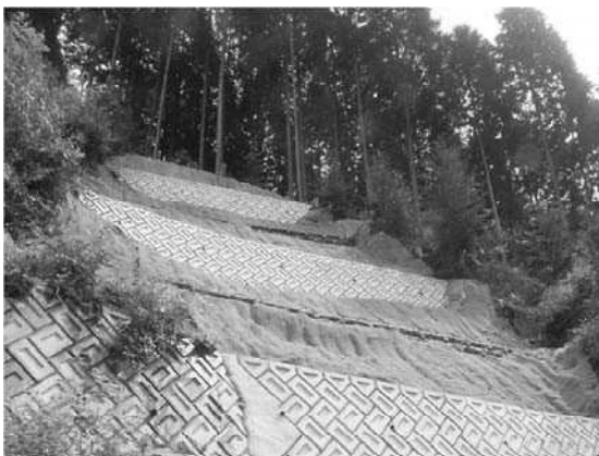
写真－6 施工直後
