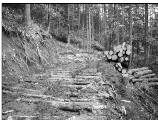
写真－6 支障木の敷き込み
