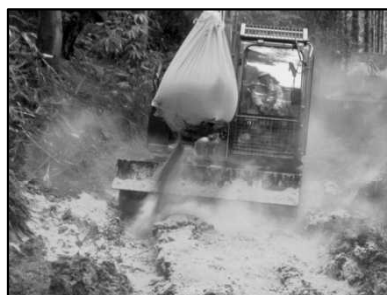
写真－7 土壌固定化剤の投入
