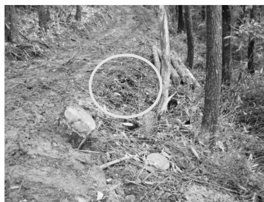
写真－9 表土ブロック積み、根株積み工法
