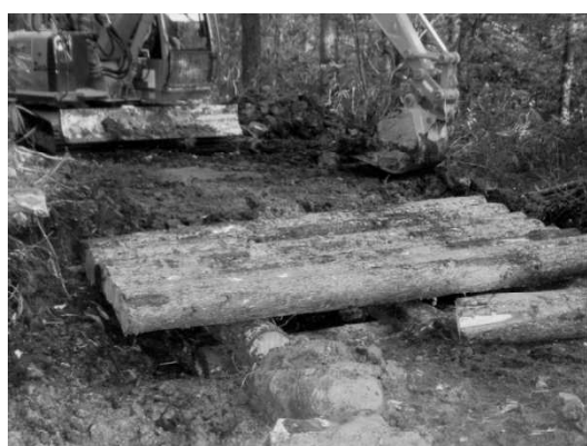
写真－8 横断水路の作設
