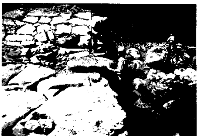
写真7 天端積石状況
