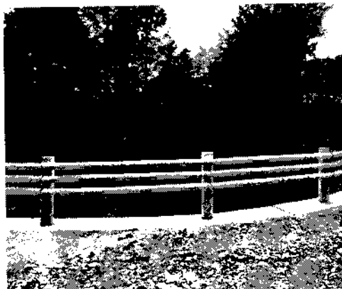
木製ガードレール
