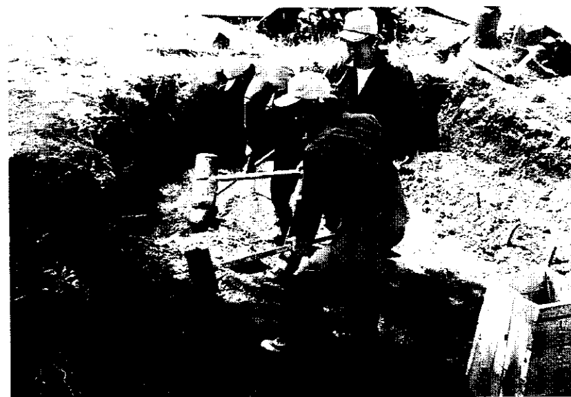
写真-4 窯底の寸法を決めて再び窯底を固める
