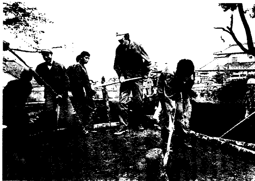
写真-13 槌で締固める
