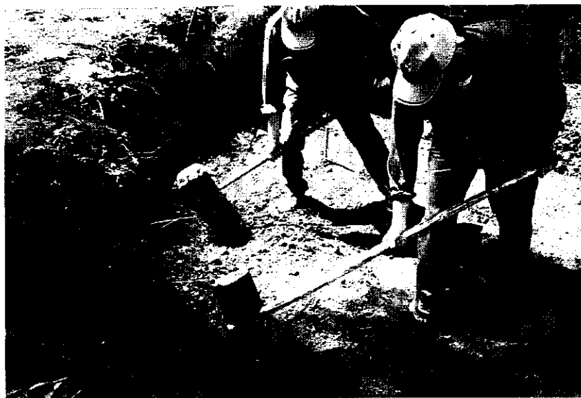
写真-1 窯底を造る
