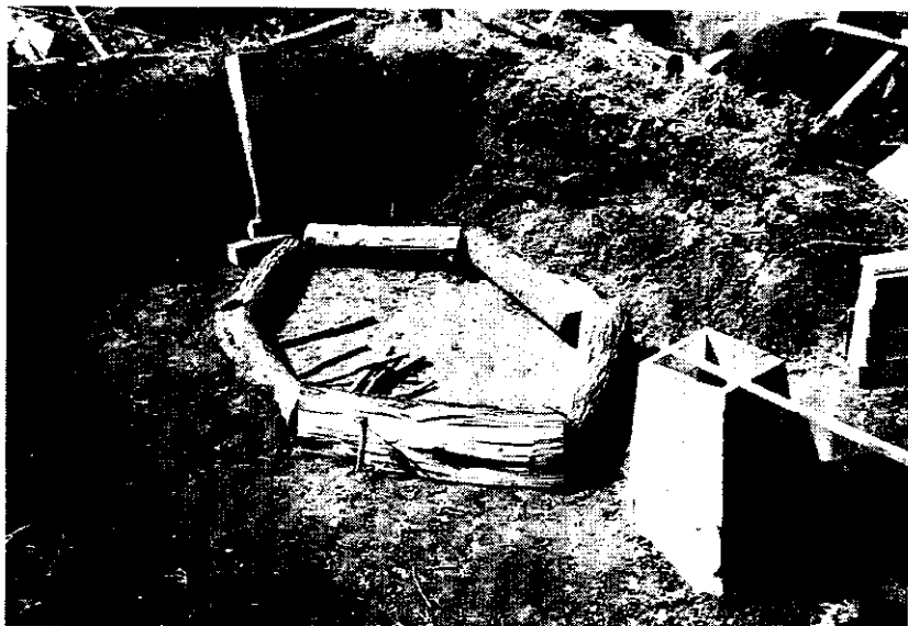
写真-7 手前が吹き口、奥に向かって窯壁の型枠、排煙口
