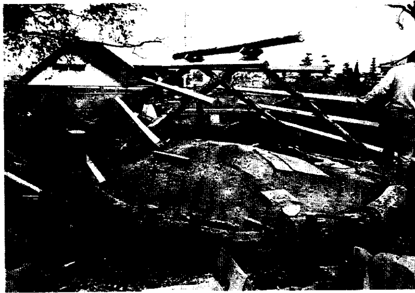
写真-15 屋根を造る
