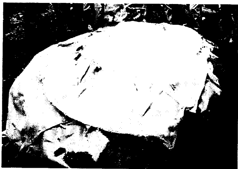
写真-12 コモを被せて土を載せる
