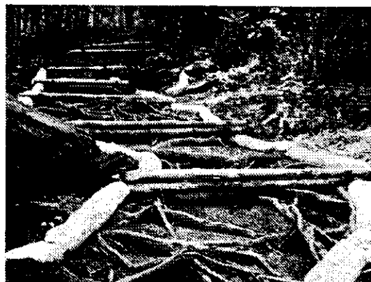
写真一七 ネットバック敷設
