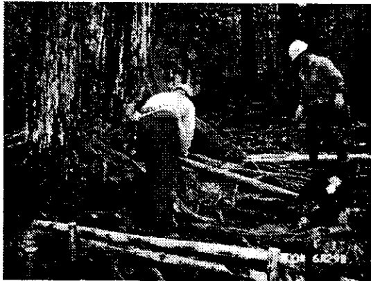
写真一六 階段工施工
