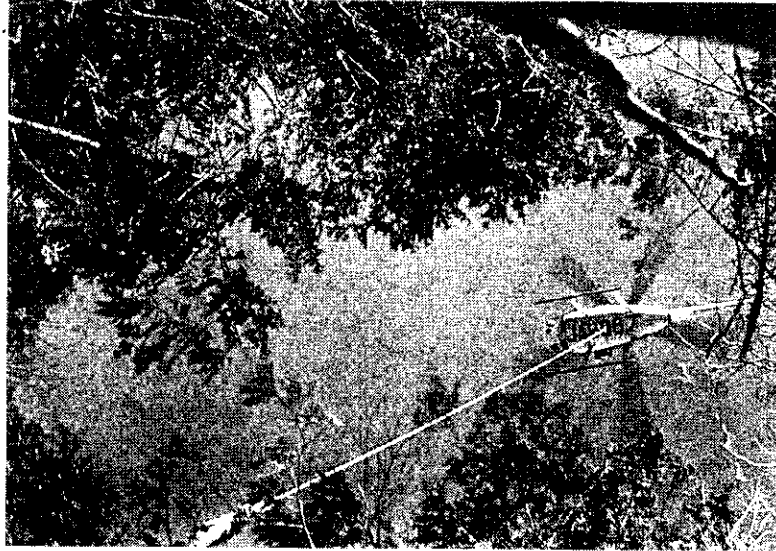
写真-5 ヘリ集材状況
