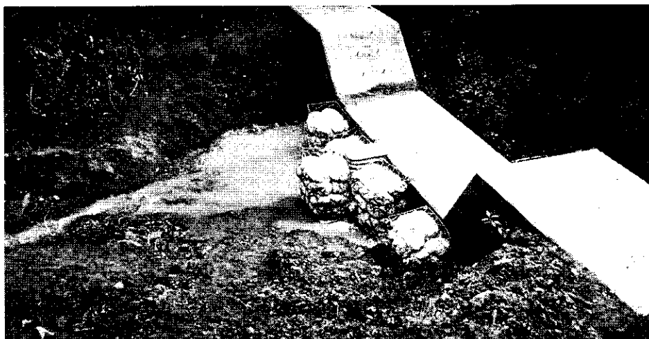
写真－10 排水促進工完成全景
