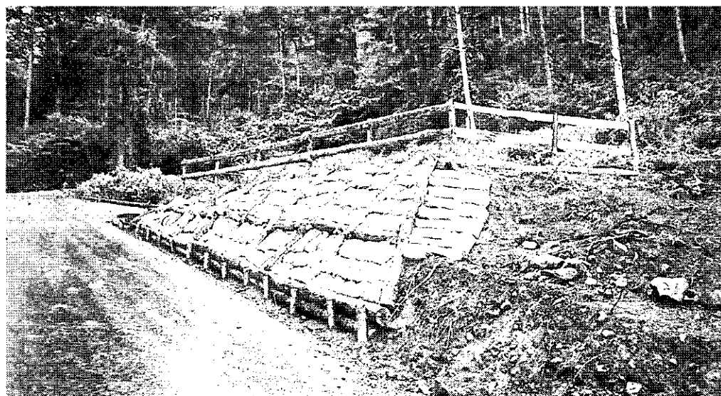
写真-8 丸太枠法面保護工
