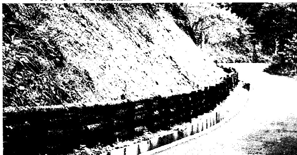
写真-6 落石防護柵
