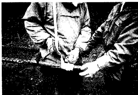
写真-6 金具による調整
