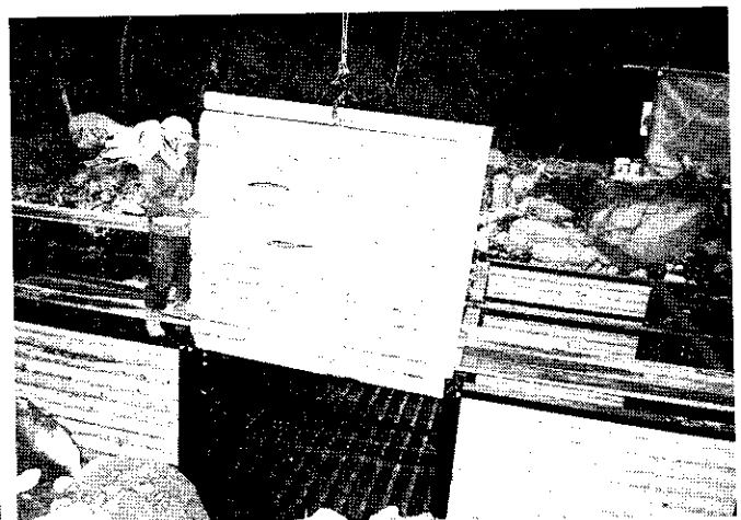
写真-2 木製パネル挿入作業
