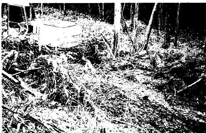
写真-8 重機による地掻の実施状況
