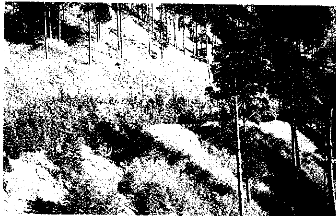
写真-6 林道法面状況図(No. 2)
