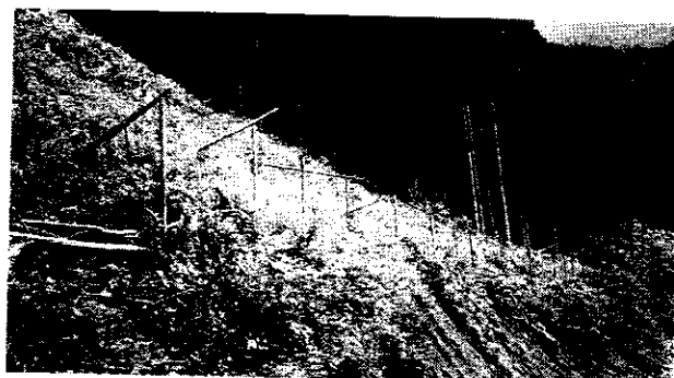
写真-4 カモシカ防護柵設置状況
