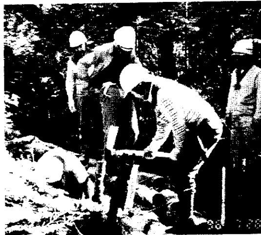
写真-5 作業風景
